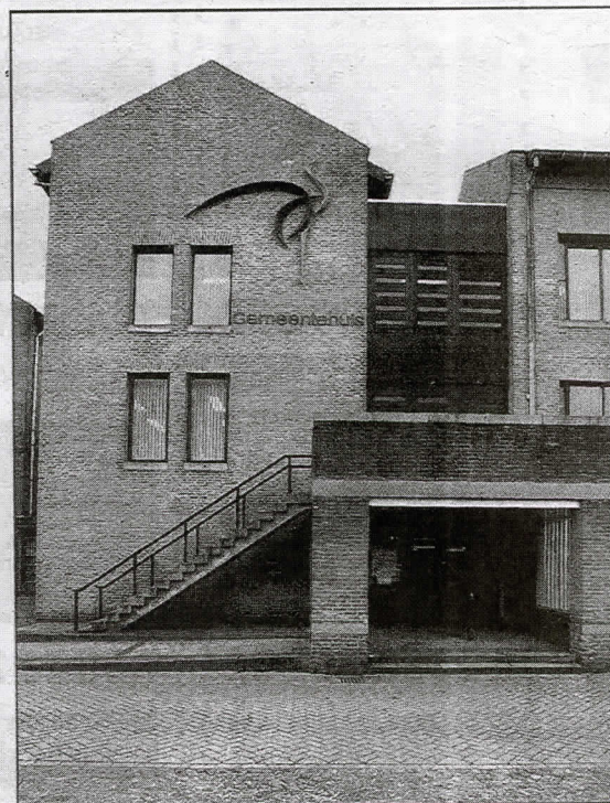
De voorzijde met op de gevel het flink uitgevoerde gemeentewapen, een steriel gestileerde Avifaunavogel.
